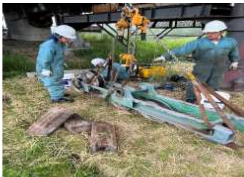
（上段：索受装置取外し準備、下段：索受装置分解）
