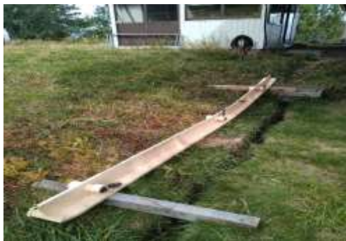
(ランプレール本体取り付け前)
