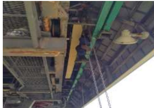
(ランプレール取り付け作業)
