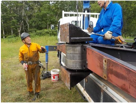
(上：作業足場仮設、下：滑車軸受組)
