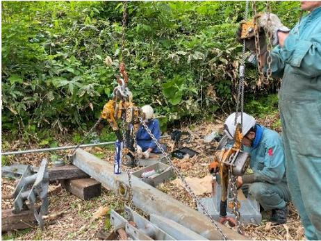
(上：索受装置取外し、下：索受装置分解)
