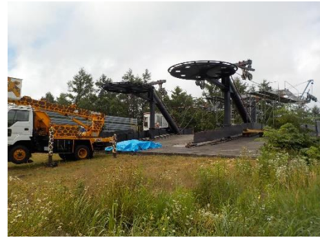
(上：滑車取外し、下：組上げ完了)
