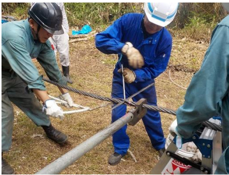
(5) パラダイス1号・パノラマ2号リフト握索機ウィング交換（新旧比較）
