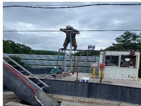
(上：搬器取外し、下：搬器取り付け)
