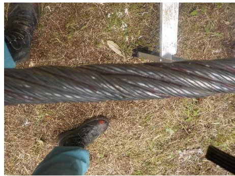
(上：切詰長さ確認、下：スプライス仕上がり)
