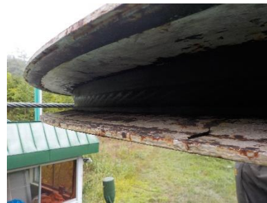
(新コンクリート取付済み)
