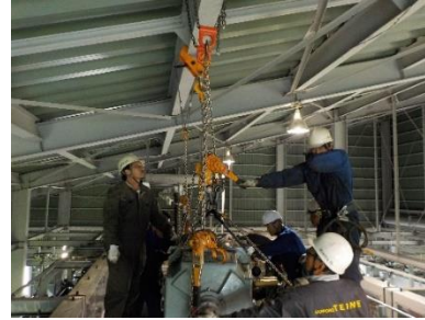
(主原動機据付作業)
