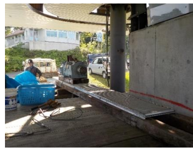
(主原動機搬出作業中)
