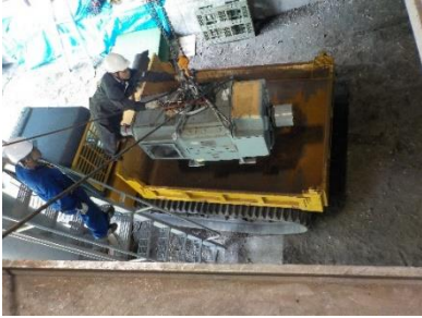
(主原動機搬出作業)
