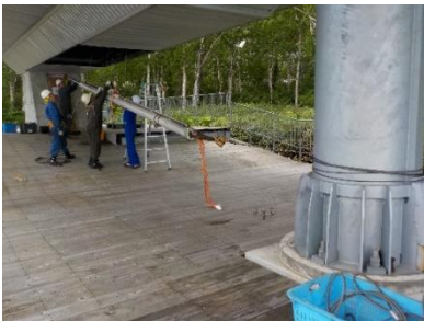
(緊張シリンダー搬出作業)
