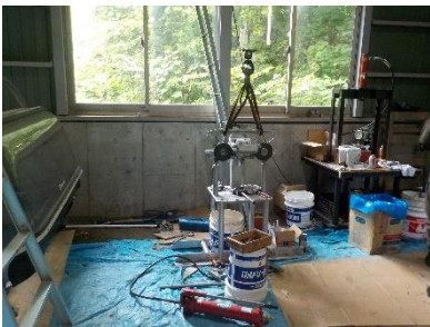
(握索機取外し整備台据付)
