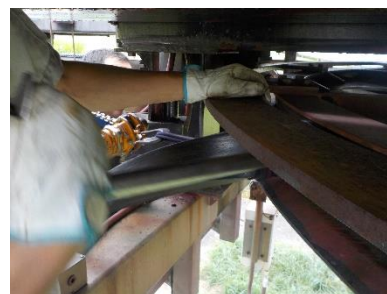
(新・旧コンクリート組替え並行作業中)
