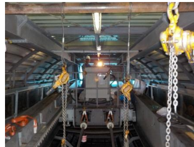
(緊張シリンダー据付作業)
