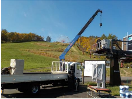
(5) パラダイス1号リフト、油圧緊張シリンダーOH
