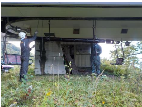
(6) パラダイス1号リフト、ランプレール張替え交換
