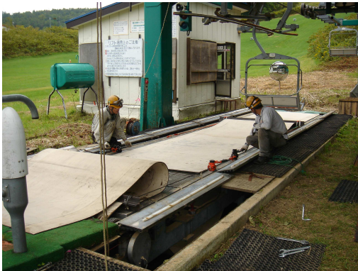
(3) 聖火台第 1 トリプルリフトのローディングカーペット交換
