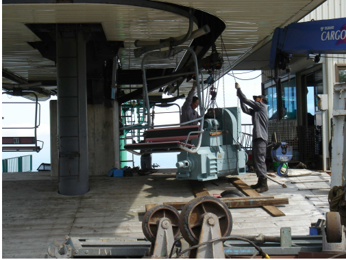
(2) パノラマ 2 号リフトの主原動機及び冷却ファンモーターのオーバーホール
